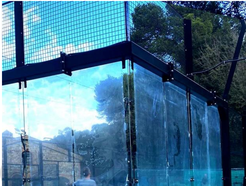
Cable de entrada por la parte superior derecha de la imagen
